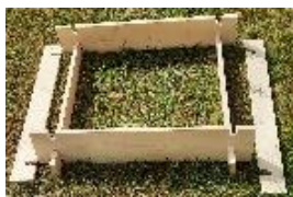
2) De två halvhöjds "startbrädorna" är på plats och sammansatta med de två helhöjdsbrädorna.
