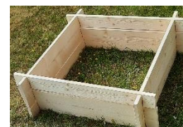
2) De två halvhöjds "startbrädorna" är på plats och sammansatta med de två helhöjdsbrädorna.
