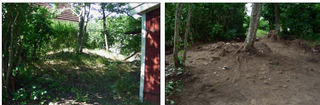
Figur 10. Stensättning 2 före och efter avtorvning. Foto mot S av Ingela Spijkerman.
