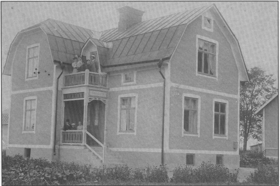
Foto: 1913. Detta hus vid Brogatan, snett emot V. Marks skola, hette Badelund och byggdes 1911. Ägaren J.L. Pettersson startade här Hjärsta möbelfabrik år 1919.
