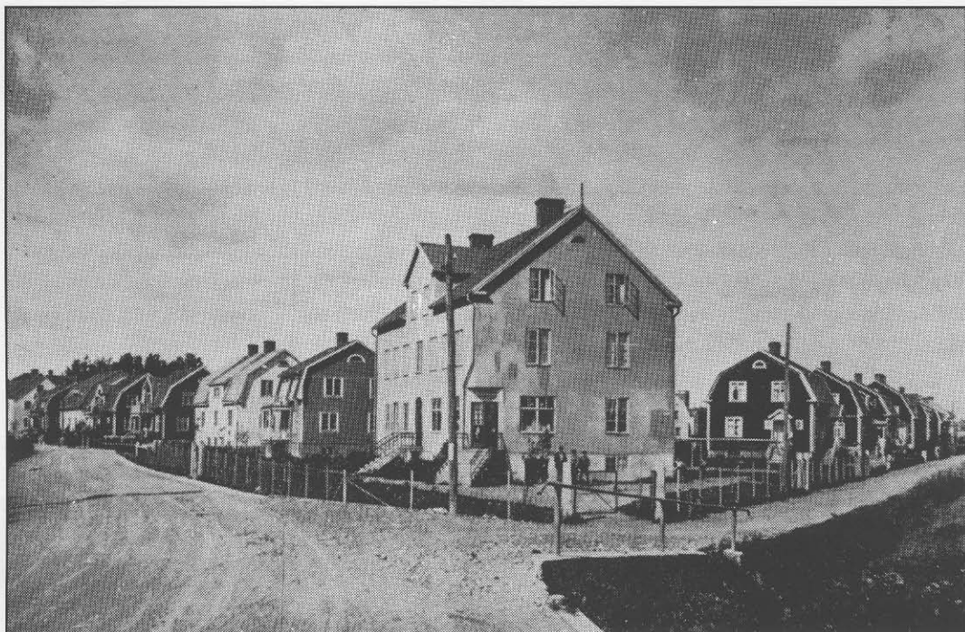
Foto: 1930. Bilden visar korsningen av Ekersvägen och Grängsgatan, numera Apelvägen-Lundbygatan. Alla dessa hus byggdes i början av 1920-talet. Det stora huset Apelvägen 2 har inrymt många företag.
