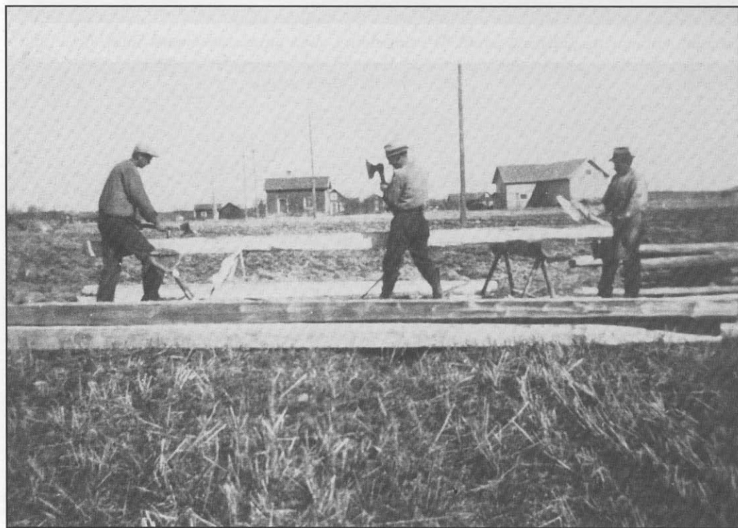
Foto: 1913. Detta är ett unikt foto som visar snickare i färd med att för hand yxa till bjälkar som skulle användas till byggandet av V. Marks skola.
