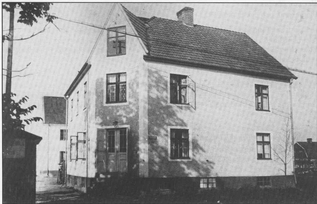
Foto: 1926. Apelvägen 16 med entrén till kaféet på hörnet. Till vänster skimtar en kioskbyggnad tillhörig Sven Månssons nystartade företag Hjärsta Lillebil.
