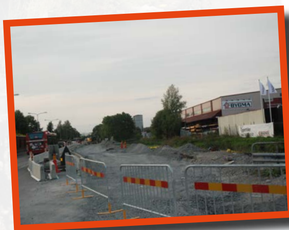
Arbetet påbörjat med den nya cykelbanan.
