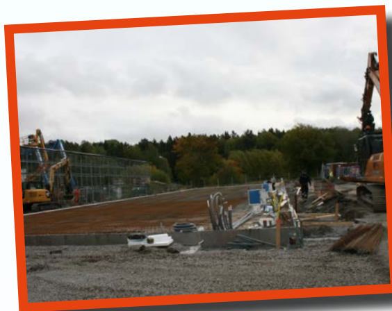
Hallbyggnadens grundarbete hösten 2018
