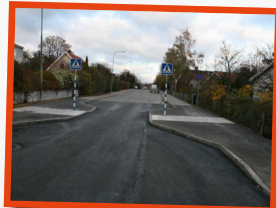
Vid oktober månads utgång låg ny asfalt på getingmidjan.
