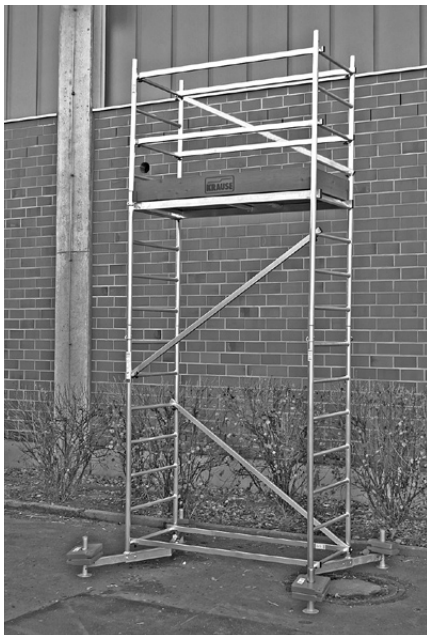
Bilden visar den färdigmonterade ställningen med första påbyggnad och 8 ballastvikter
