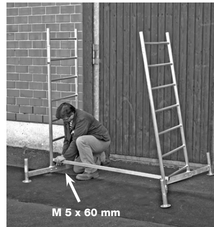
Grundställning med första påbyggnad
