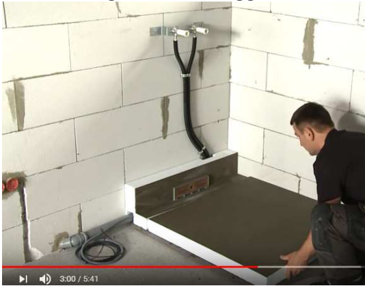
Figur 15 Exempel på väggbrunn i prefabskivsystem.
