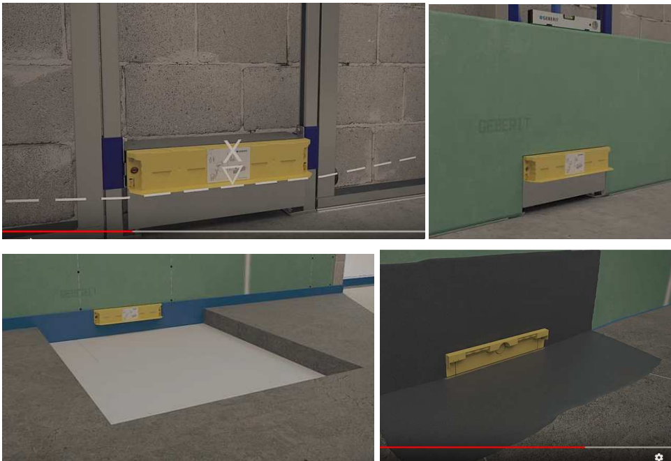
Figur 16 Exempel på komplex väggbrunn i lättregelsystem på tung bakvägg.
